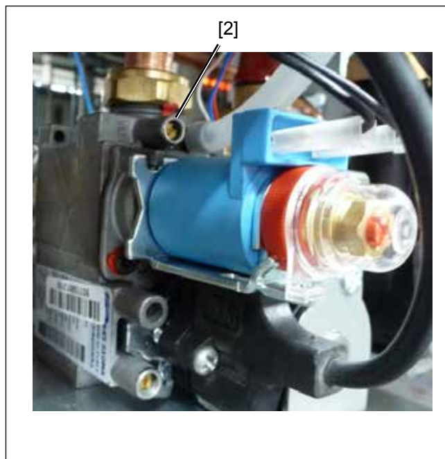
Рис. Штуцер для измерения давления в сопле
