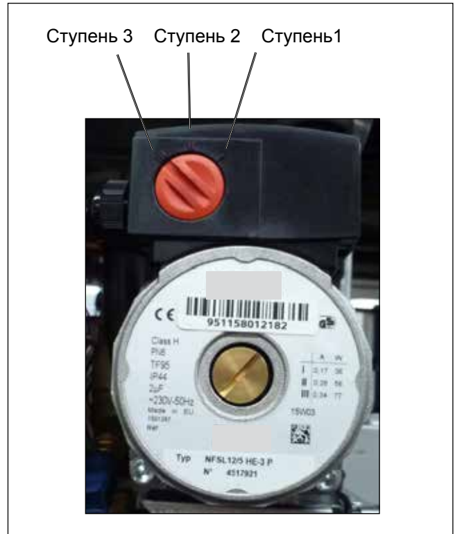
Рис. Ступени переключения насоса
